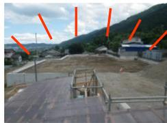
何層かに分けて土を埋め戻し、転圧して固めていき、造成工事の完了です!
