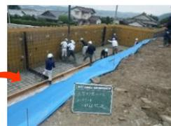
型枠の中に鉄筋を組み、生コンクリートを流し込みます。
