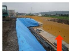
コンクリート擁壁の形状を形取る型枠工事の様子です。
