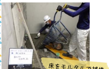
床をモルタルで補修。
