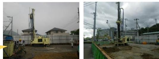
地盤改良（柱状改良）工事の様子
