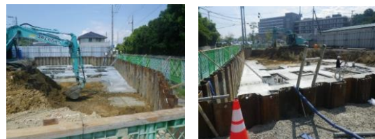
基礎掘削の状況
