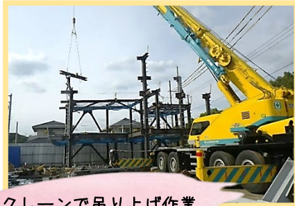
クレーンで吊り上げ作業
