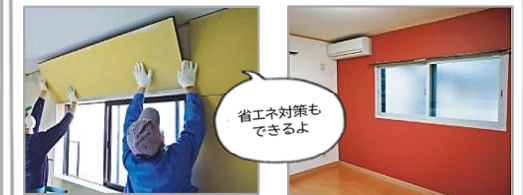
パネル取付作業中
